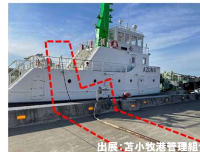
出展: 苫小牧港管理組合 (船溜まりの陸上電力供給)
