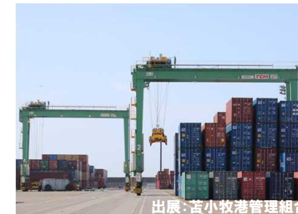
出展: 苫小牧港管理組合 (CTのハイブリッド式RTG)
