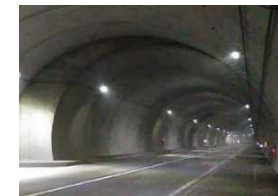
国道230号三豊トンネル(洞爺湖町)
