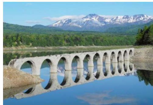
タウシュベツ川橋梁
