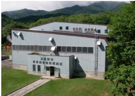
リサイクルセンター 固形燃料化施設
