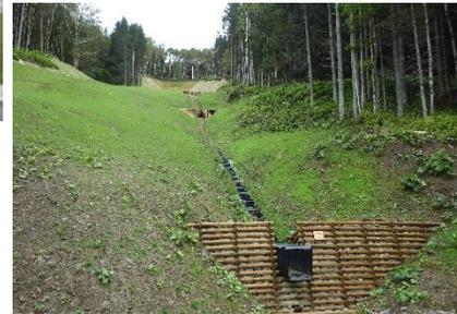
山腹斜面の土砂の移動を防ぐなどの
