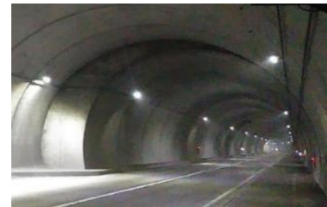
道路照明灯のLED化を推進し、CO 2 排出量を削減
