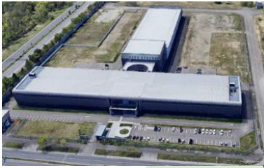
石狩データセンター
