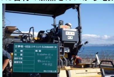
AS材の加熱をガスから電気
