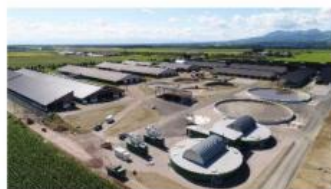
バイオガスプラント
