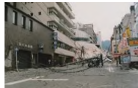
建物倒壊による道路閉塞
