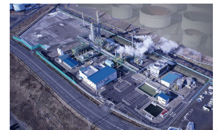
炭素回収・貯留施設
