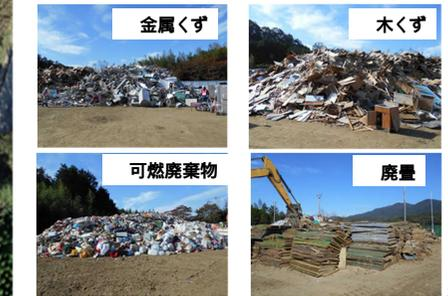
搬入された災害廃棄物は、ドローン等により堆積を計測し、種類毎に見掛け比重を乗じて、重量を算出する。
