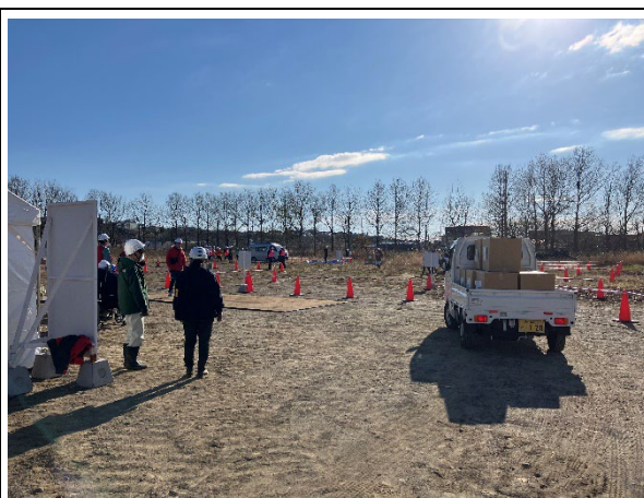
仮置場内周回の様子
