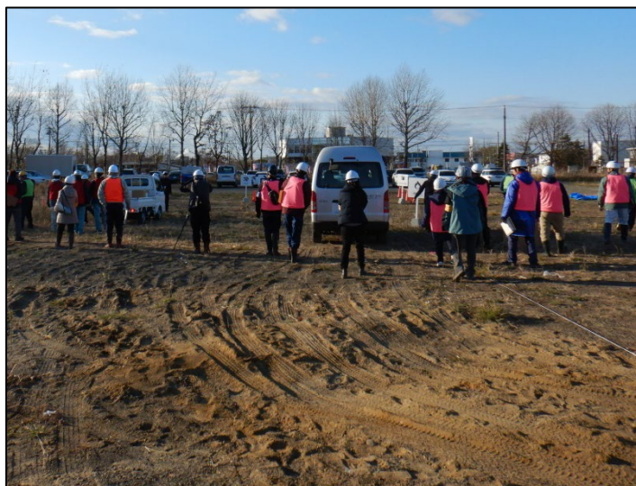
図 2.2.3-3 わだち掘れにより凹凸のできた地面
