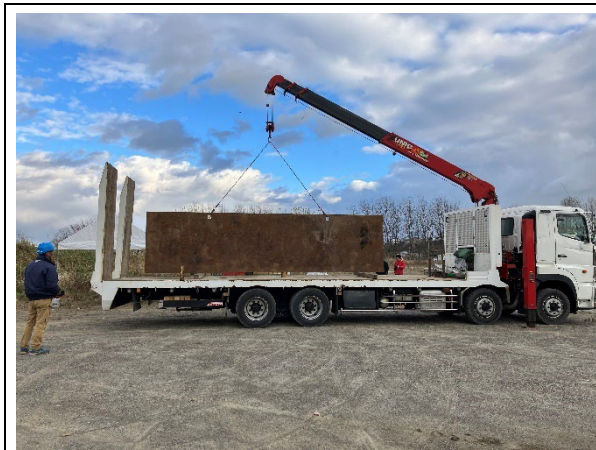
敷鉄板の設置
