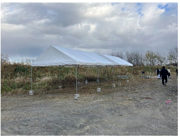
受付テントの設置
