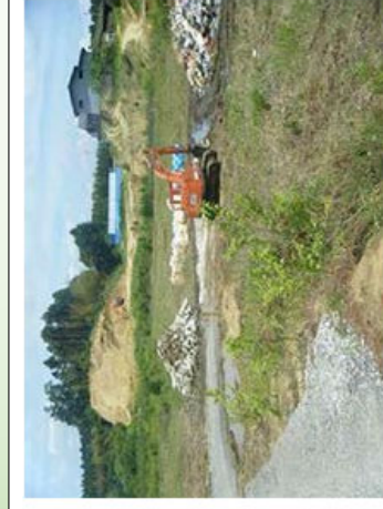
搬入路に砕石を敷き、水溜まり解消を図っている (松島町)
