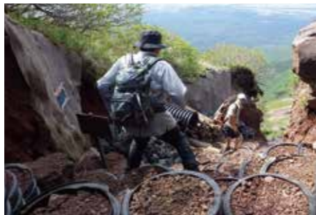
頂上直下にある3メートルスリットの整備。コルゲート管に火山礫であるスコリアをつめて土壌を固め、植物が根を張りやすい環境をつくる。
