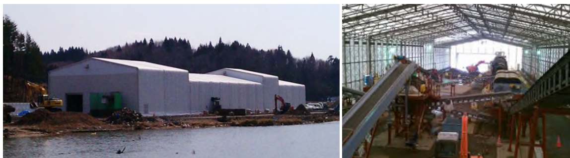
写真4-6-1 大型テント内での処理
