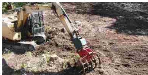
大型機械による地拵え
