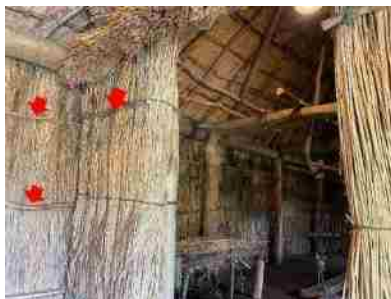
チセを葺くヨシを押さえるサクマ 広葉樹のしばを利用
