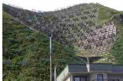
山腹斜面を安定させる山腹工 (令和5年8月完成)
