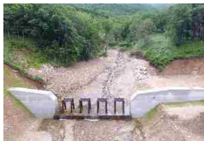
流木を捕捉する溪間工 (令和5年12月完成)
