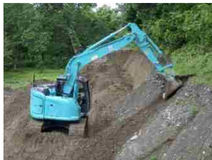
ICT建設機械を活用した施工
