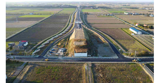
中樹林道路 施工状況
