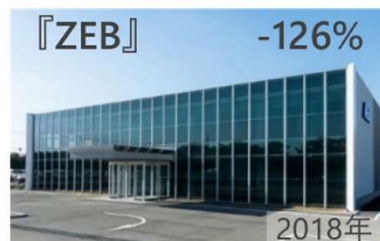
AGC鹿島工場 本事務所棟
