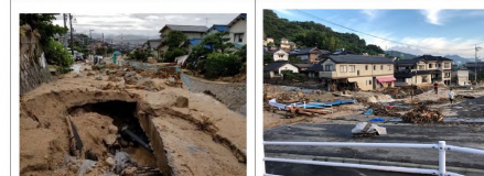
被災状況写真 ⑤
