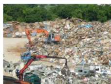
災害廃棄物の仮置場の管理
