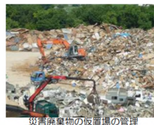
災害廃棄物の仮置場の管理
