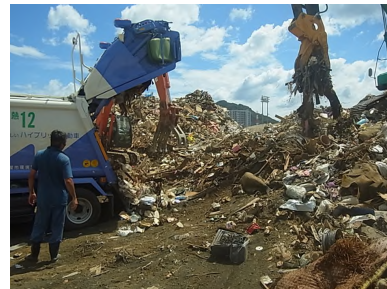
一次仮置場設置運営の事例
