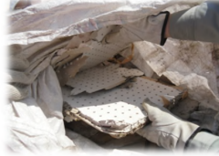
石膏ボード集積状況(宮城県)
