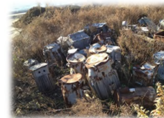
トランス等の保管状況（宮城県）
