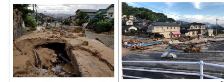
被災状況写真 ⑤
