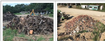
解体系木くず
