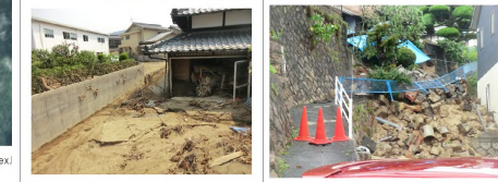
被災状況写真 ③
