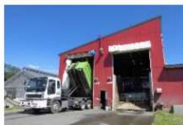
鹿追町バイオガスプラント
