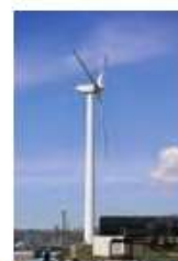
風力発電所の電力からグリーン水素を製造
