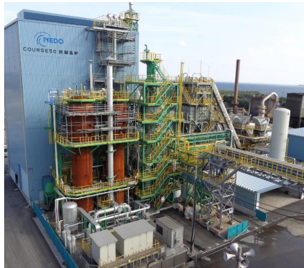
12m 3 小規模試験高炉(水素還元)
