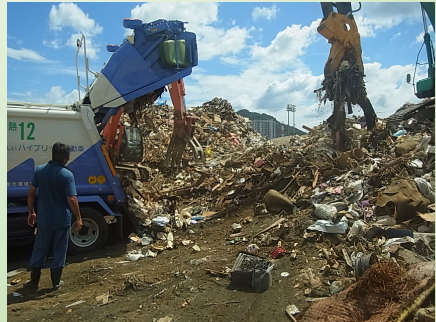
一次仮置場設置運営の事例
