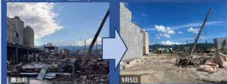
輪島朝市における解体・撤去工事
