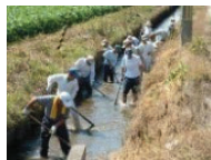
水路の泥上げ
