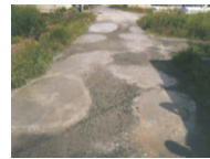
農道の窪みの補修
