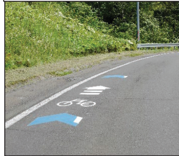
矢羽根・路面標示の設置
