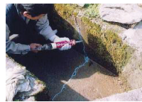
水路のひび割れ補修
