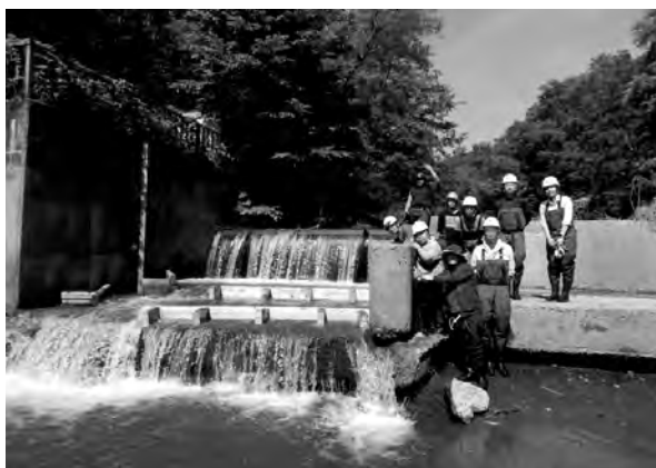
写真-3 アベツ川下流部の頭首工に設置した木製の簡易魚道（市民魚道）
