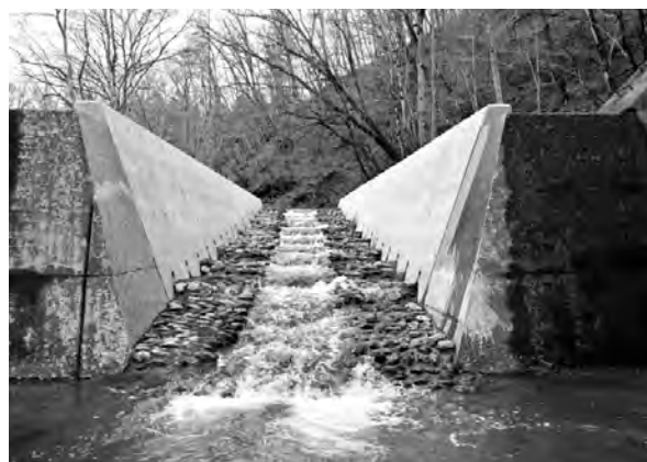
写真-4 アベツ川上流部の治山ダムに設置した引込式石積み魚道
