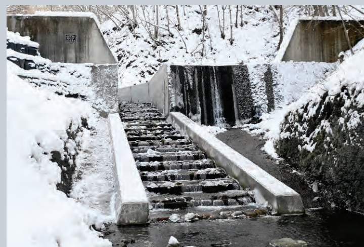
R7年度施工・チマルラの沢谷止工の魚道
