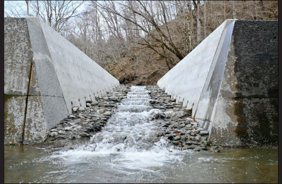
アベツ川S60谷止工の引込式石積魚道 (R6年度設置)
