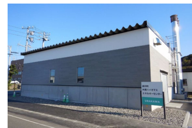
浦河町木質バイオマス エネルギーセンター
