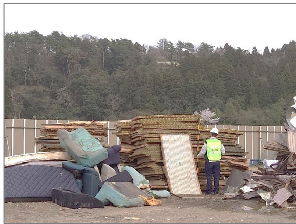
仮置場設置の技術的助言（穴水町）
