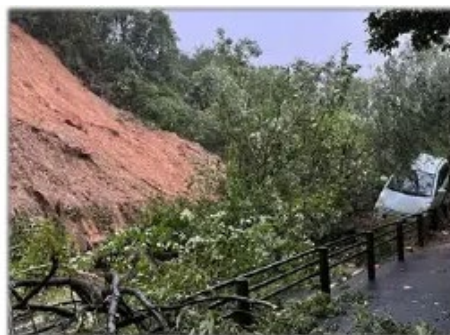
法面崩壊（上天草市）
