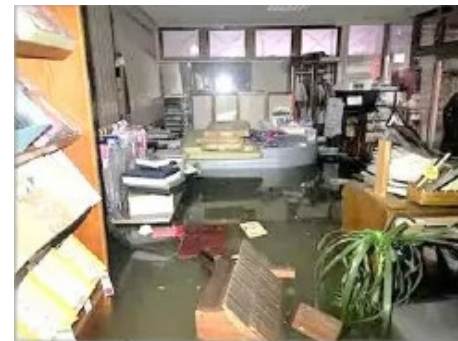
浸水被災店舗（玉名市）
