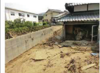
被災状況写真 ③
