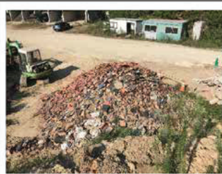
コンクリートがら
