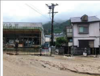
被災状況写真 ①
