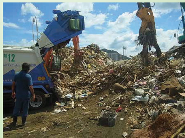
一次仮置場設置運営の事例
