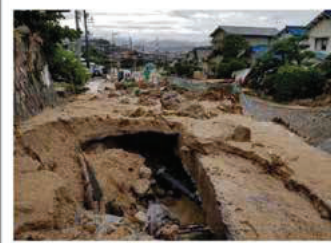
被災状況写真 ⑤
