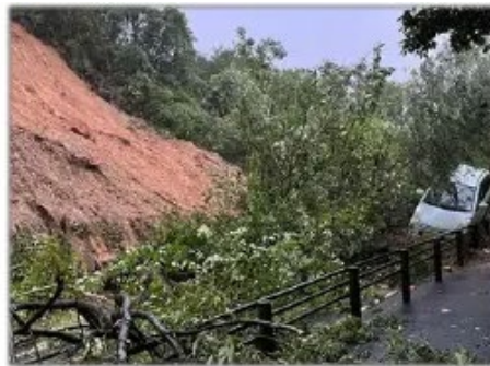
法面崩壊（上天草市）
