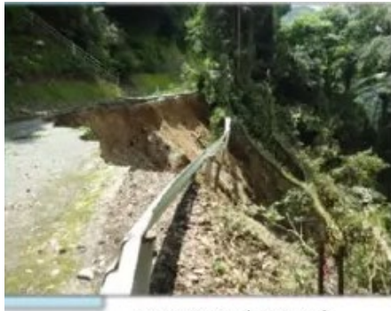
道路崩壊（甲佐町）
