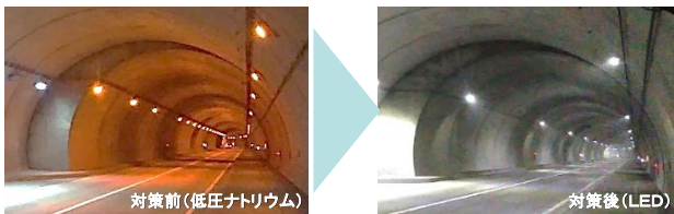
国道230号三豊トンネル(洞爺湖町)
