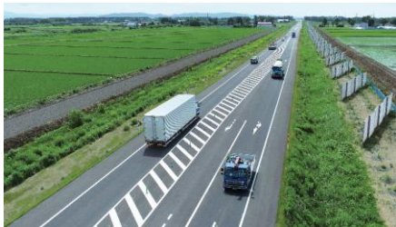
国道337号 道央圏連絡道路 中樹林道路(R7.3.15開通)
