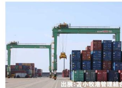
出展: 苫小牧港管理組合 (CTのハイブリッド式RTG)
