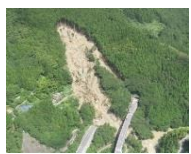
豪雨による大規模な山地災害
