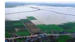
集中豪雨による農地の湛水被害
