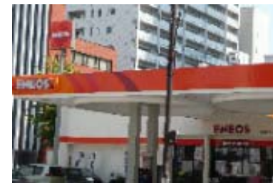
同盟石油(株)北1条給油所
