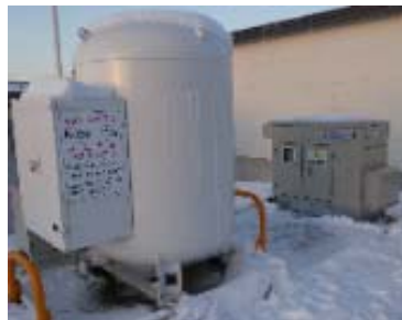
LPガス災害バルク貯槽、発電機
