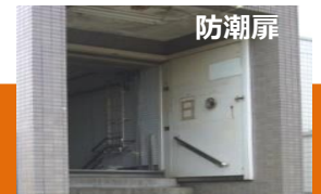
地下鉄出入口の浸水対策
