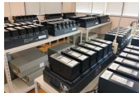
ドローンのバッテリー充電施設
