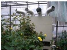
施設園芸用ヒートポンプ
