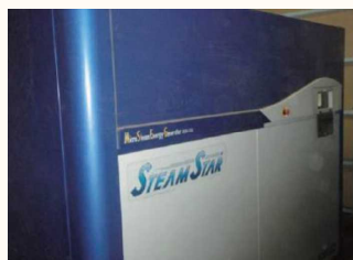
小型蒸気発電機
