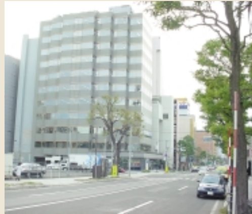
北2条通りから見た ユーンネットビル 9階が事務所
