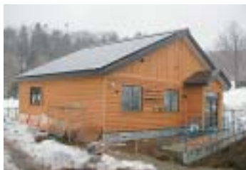
工事中のキャンプセンター兼登山センター
