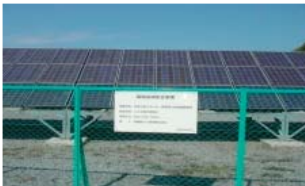
補助事業により設置された太陽光発電パネル
