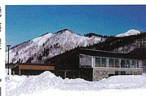
▲フィールドハウス外観
