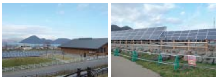
設置工事中の太陽光パネル（左側：全景、右側：近景）
