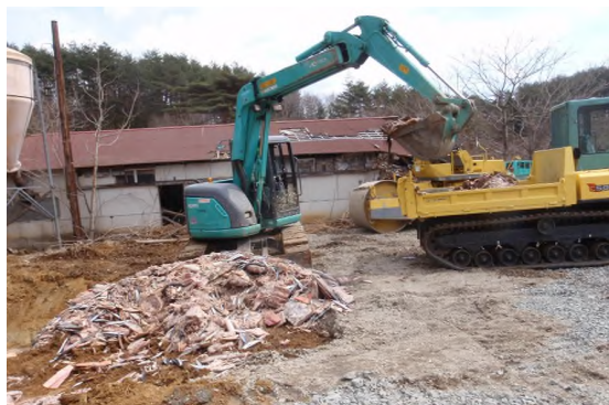
キャタピラダンプへの積替え
