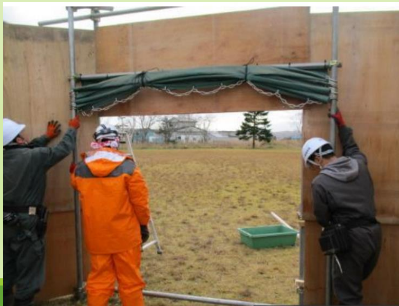
●誘引部のコンパネ設置作業
