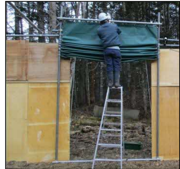
○今年度のゲート 材質：テント生地 高さ：約2.5m
