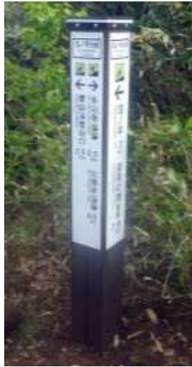
上部木製、基礎は鋼製パイプ (大雪山で採用した組み立て式の誘導標識)
