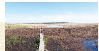
湿原の水位低下防止のための堰
