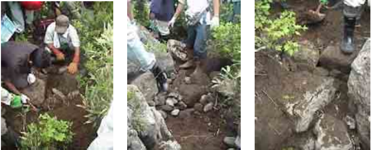
写真 21 大きめの石をはじめに組み合わせた後、小石を飼わせて補強する。背面はぐり石を詰める。
