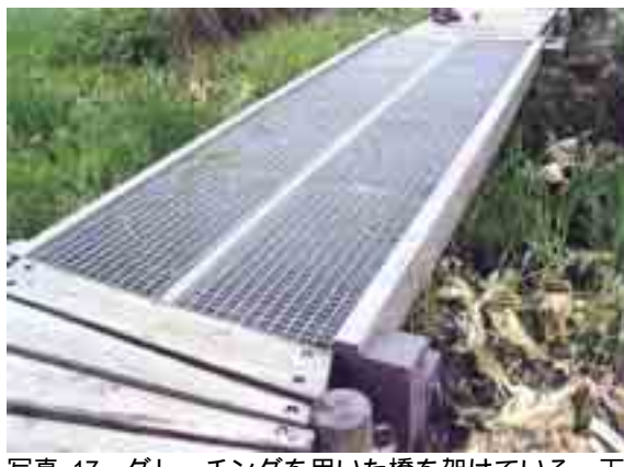
写真 17 グレーチングを用いた橋を架けている。下部に光はいるため植物も生育する。ボリュームが大きくなるため注意が必要。
