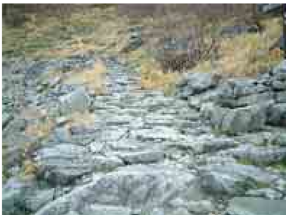
写真 10 山小屋等の管理者により自然石を用いた登山道の整備がなされている。
