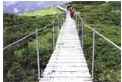
写真 28 大山山頂部の木道 (地面から 1 m 程度高く設置)
