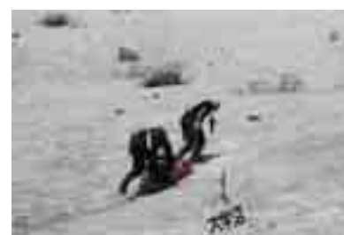
写真20 橇による石の運搬 (提供：佐藤委員)
