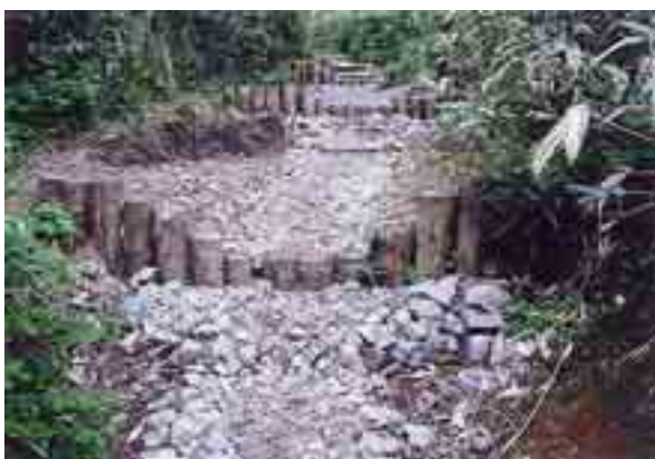
写真 14 浸食の進む部分で丸太土留めと栗石・蛇籠の暗渠排水による対策。(土木的处理に違和感もある)
