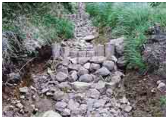
写真 15 同様の対策が急勾配箇所で行われているが、側面部の浸食への対策も必要となる。
