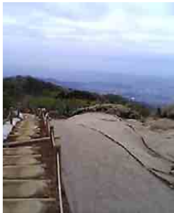
丹沢での植生マットによる植生復元（シュロマットで土壌の移動を防ぐとともに、種子を捕捉して植生回復を図る。） 植生マットについては目の粗いものを用いて、土壌粒子、種子の固定化ができるよう配慮する必要がある。
