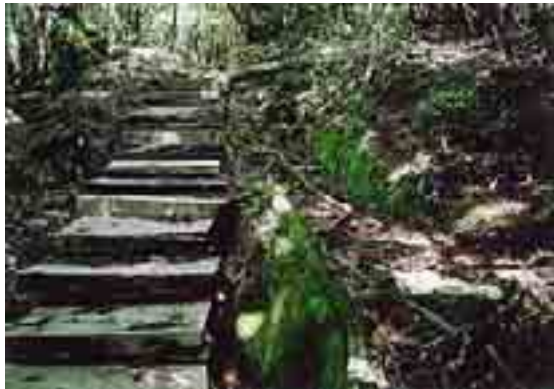
写真 6 土埋木を現地加工して段差処理を行った例 (森林事業者による)
