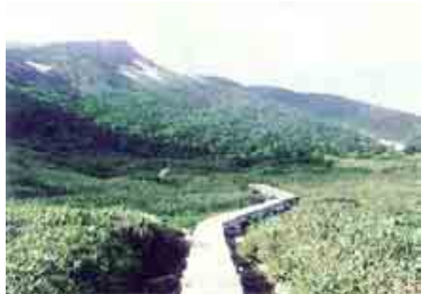
写真 9 南竜が馬場の湿原でガリー化した部分をフトン箆基礎の木道により、土砂の堆積を図っている。
