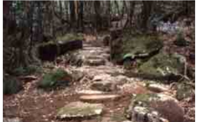
写真 7 益救参道（龍神杉歩道下部）で自然石を用いて整備した事例（写真提供：福留委員）
