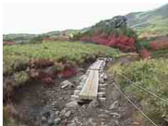
写真 47 木道設置箇所
