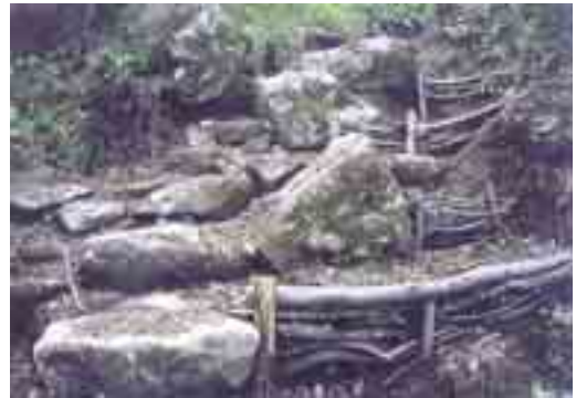
写真 37 木材による土留め
