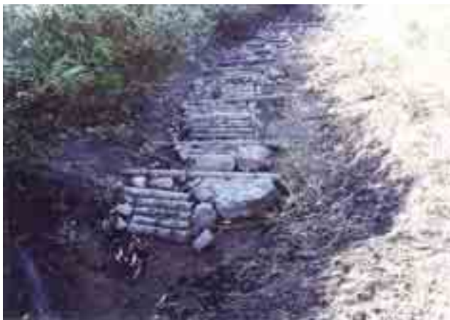
写真 44 愛山溪での丸太による階段処理
