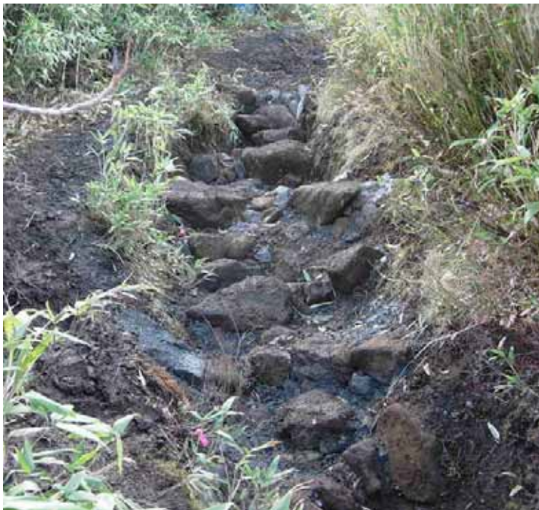
平成 17 年度施工の石組み工例（施工後）
