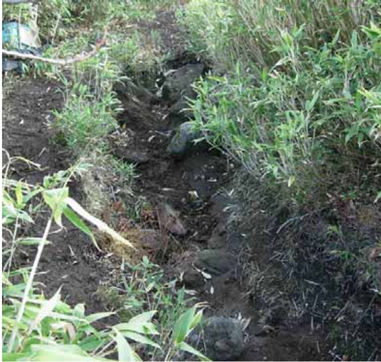
平成 17 施工の石組み工例（施工前）
